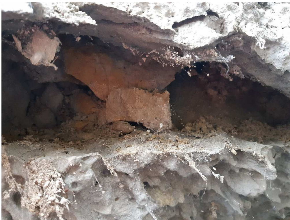
Foto č. 9 – Detail kamenného zdiva čelních zídky pod torkretem.
