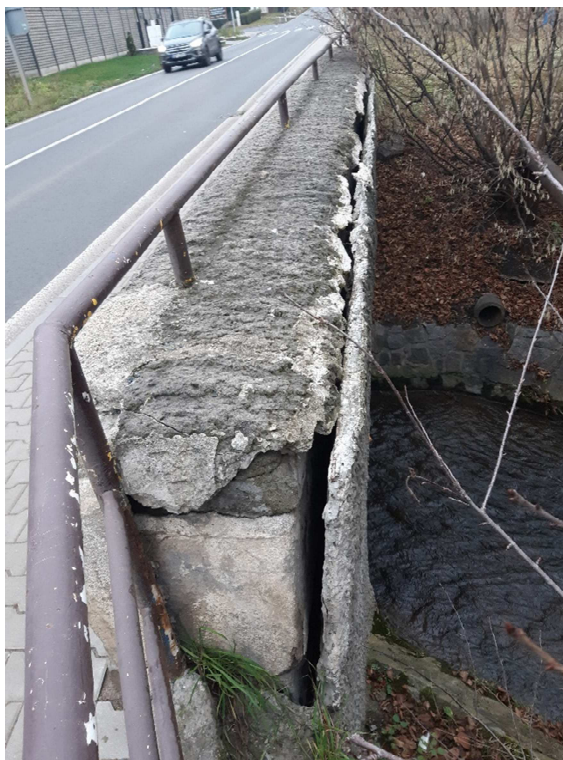
Foto č. 8 – Separace torkretu na povodní straně mostu.
