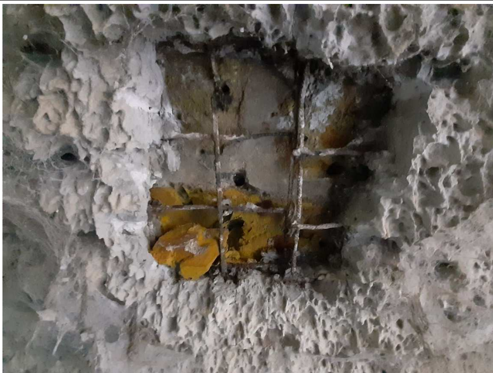
Foto č. 9 – Detail odhaleného kamenného zdiva nosné konstrukce.
